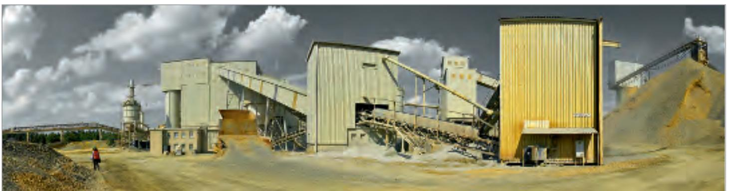
Foto 2: Vollständig eingehauste Brecher- und Verarbeitungsanlage des Steinbruchs Koschenberg.
