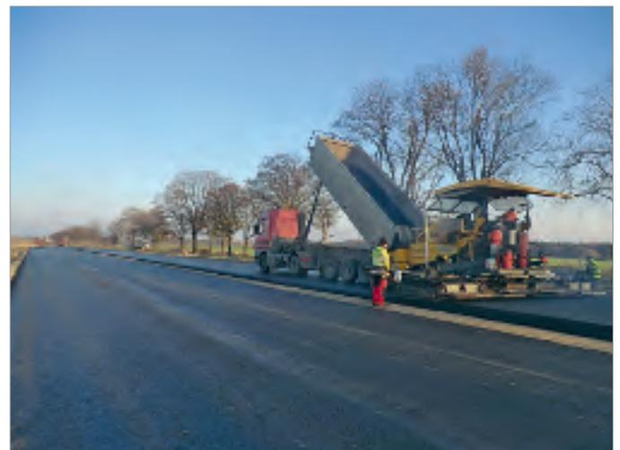
Bild 2: vierstreifiger Ausbau auf nördl. Seite neben der vorh. Fahrbahn der L 33
