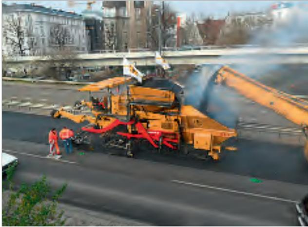
Bild 2: Fertiger (Beladung Binderschicht)
