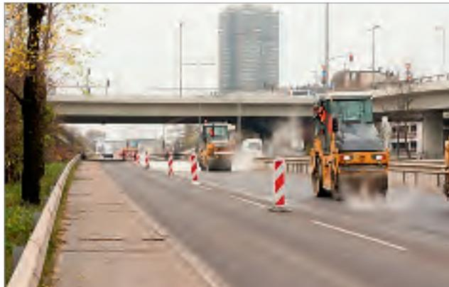
Bild 3: Walzeneinsatz zur Hauptverdichtung
