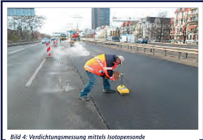
Bild 4: Verdichtungsmessung mittels Isotopsonde
