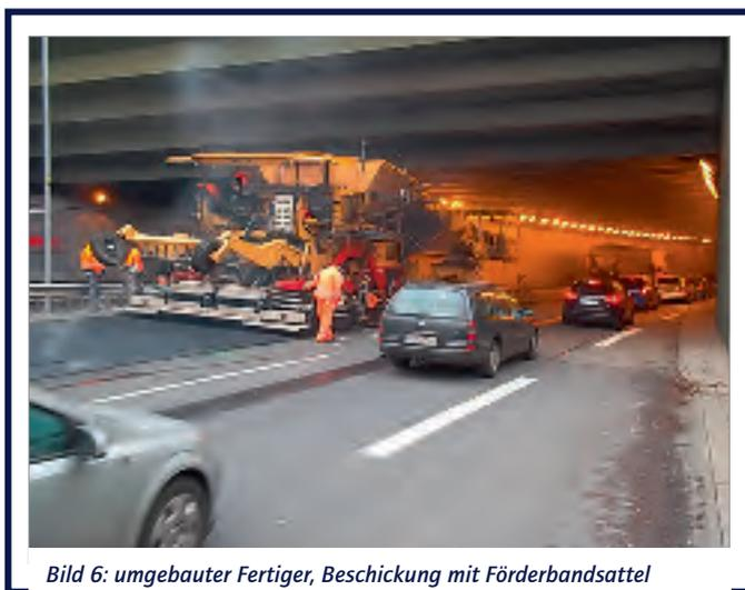
Bild 6: umgebauter Fertiger, Beschickung mit Förderbandsattel
