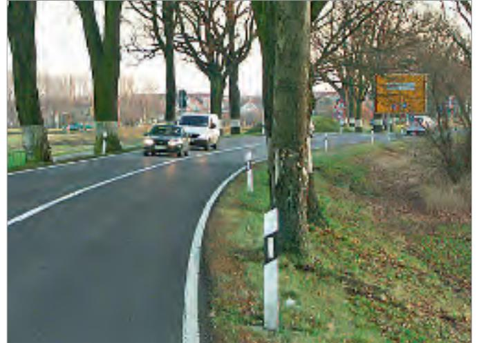
Bild 6: Der Vorwegweiser hinter der Rechtskurve wird durch Bäume verdeckt, die unmittelbar folgende Kreuzung ist erst sehr spät erkennbar
