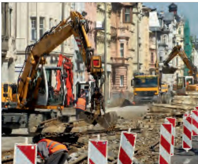
Abb.8: Baubeginn mit dem Rückbau der Gleise auf der Westseite
