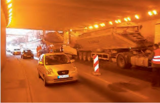
Bild 9: umgebauter Fertiger, Beschickung mit Förderbandsattel
