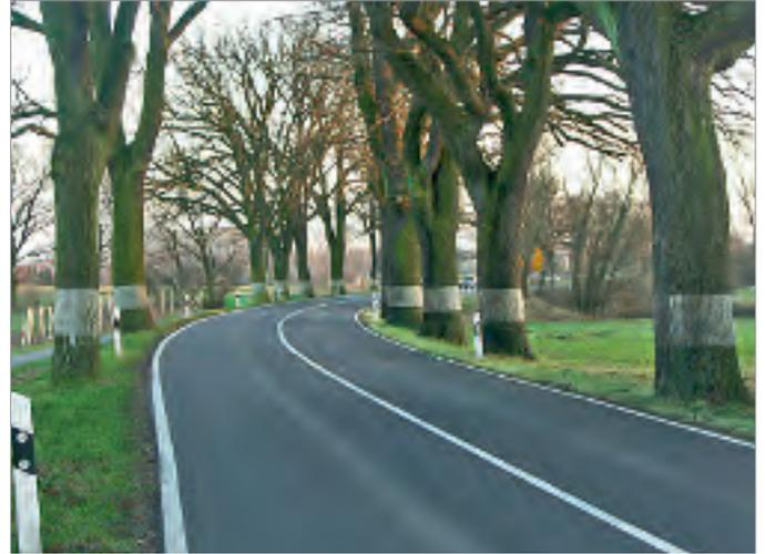
Bild 1: Typische Situation - Kurvenbereich mit schlechten Sichtverhältnissen und fehlender Fahrbahnaufweitung
