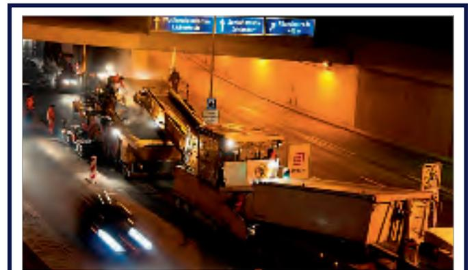
Bild 10: Rückbau Aufsatz Förderbehälter für Deckmischgut
