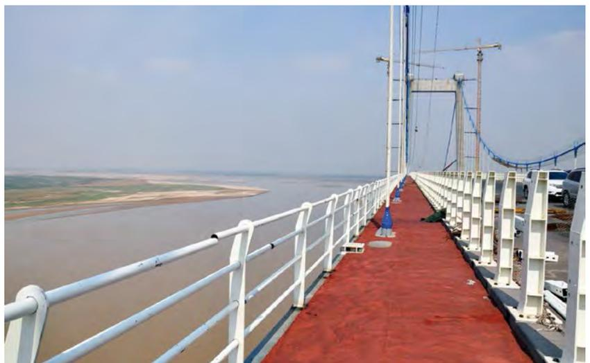
In ihrer speziellen Bauart als „unechte Hängebrücke“, mit der Verankerung der Tragseile auf der Brückenplatte selbst, ist diese Brücke mit einer Spannweite von 406 m zwischen den Pylonen und einer Gesamtlänge von 726 m die größte ihrer Art in der Welt. Landesüblich wurde unser Baustellenbesuch hier mit einem üppigen Mittagessen abgerundet.
