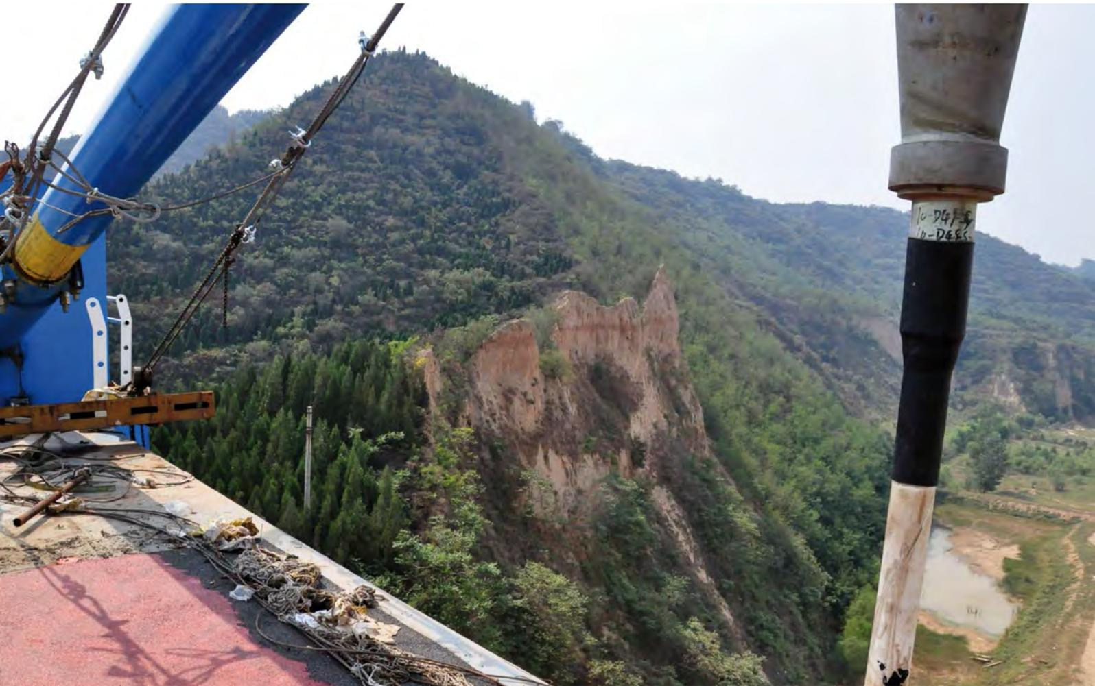
^ Verankerung des Tragseils auf der Brückenplatte
