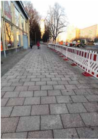
^ 2018: neue Gehwegplatten, parallel verlegt im westlichen Abschnitt
