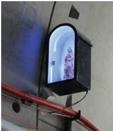
^ Rastatt DB Tunnel – Die Heilige Barbara, Schutzpatronin der Bergleute – ein „Muss“
