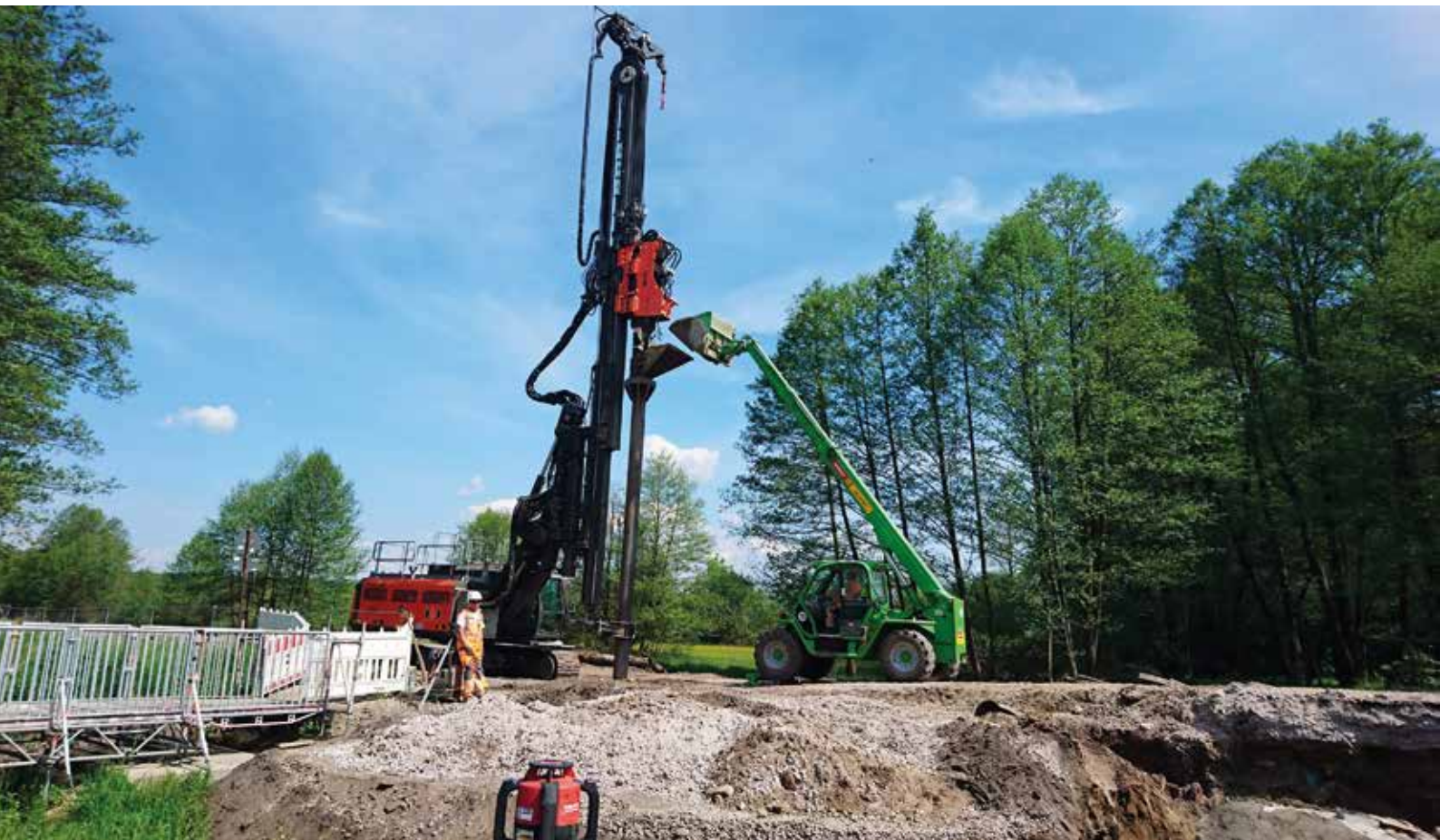
Einbringen der ROB-Säulen
