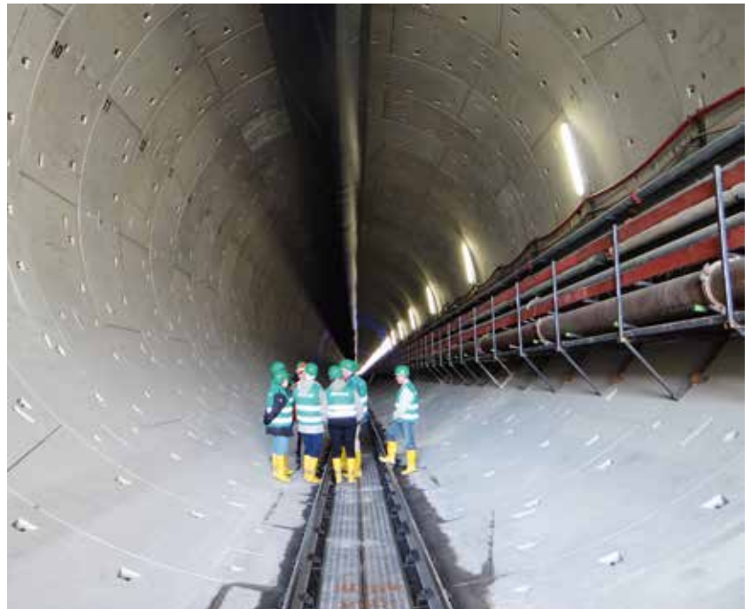
‹ Rastatt DB Tunnel – Tunnelröhren Segmente – der Einbau ist vorbestimmt
