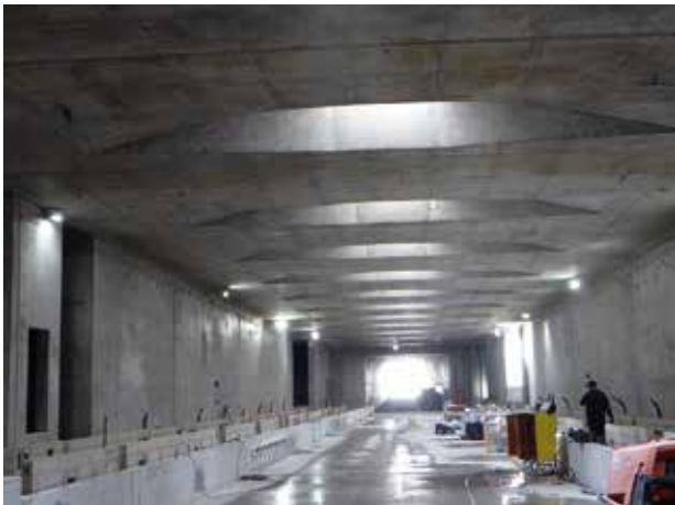
^ Karlsruhe Kombilösung – Zugang Haltestelle Marktplatz
