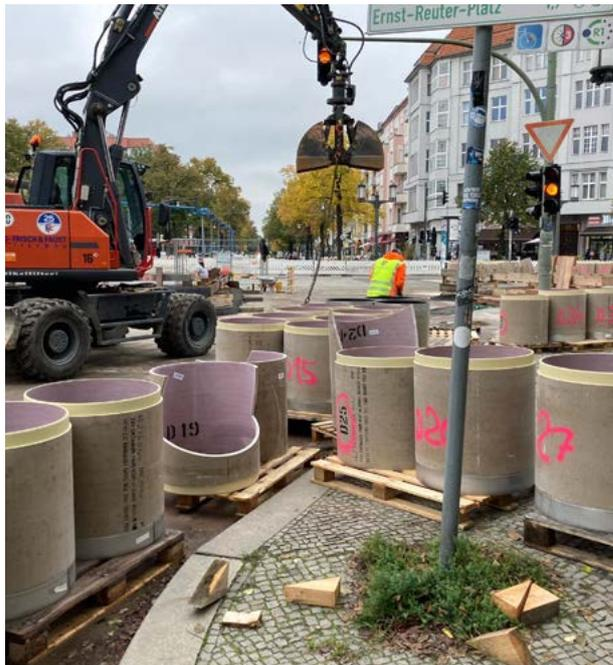
Mit diesen individuell gefertigten GFK-Inlinern wurden vier der sechs Dükerleitungen DN 800 saniert.
