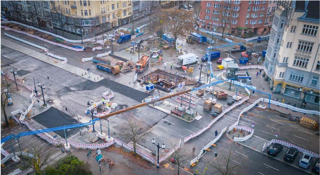
Die Baustelle im November 2023 mit Baugrube am Dükteroberhaupt, mit kleinem Zaun markiertem Unterhaupt und Rohrbrücke für den Überpumpbetrieb. (Luftbild: Berliner Wasserbetriebe/Sven Bock)
